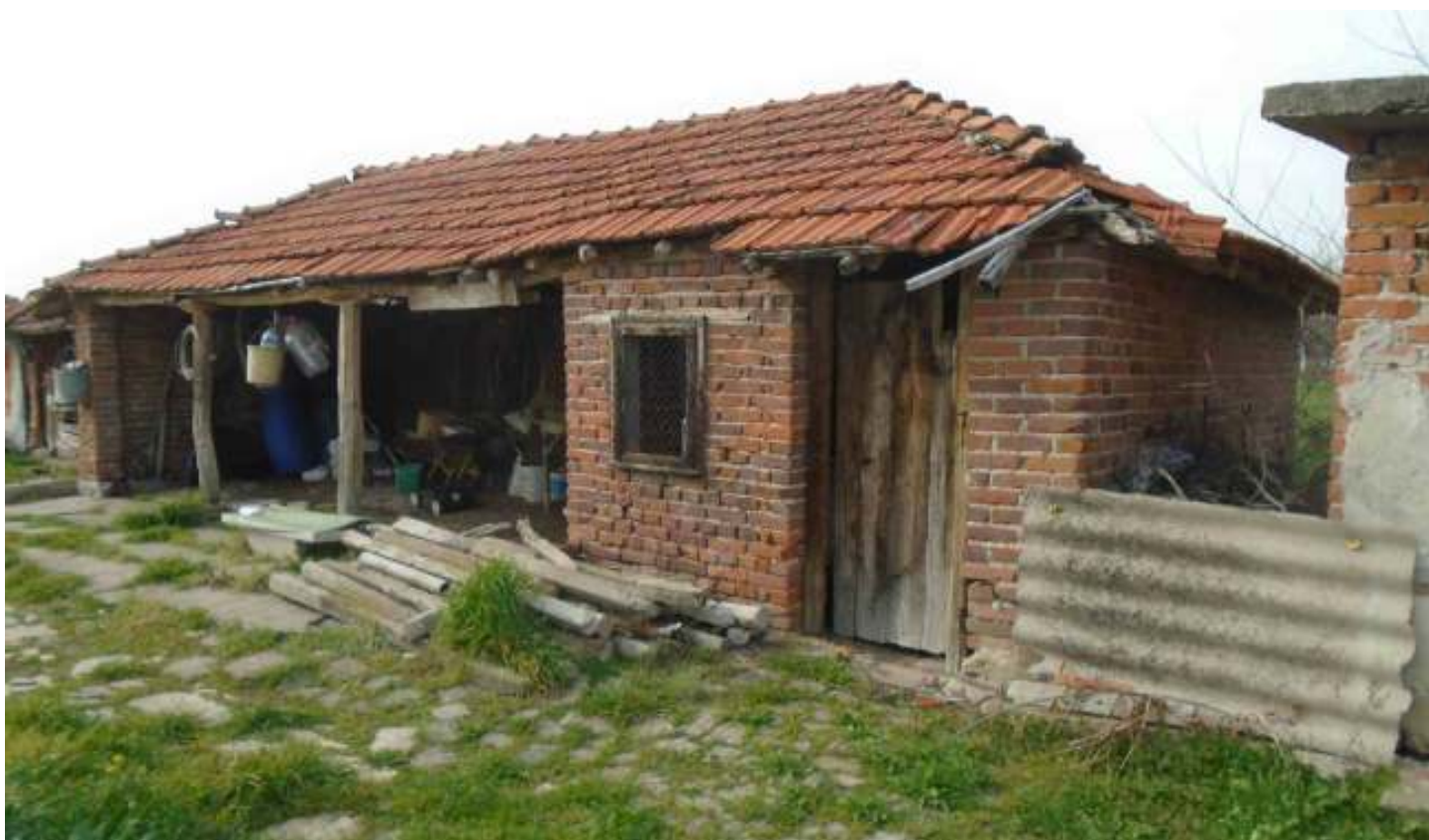
Стопанска построка - изглед от югоизток
