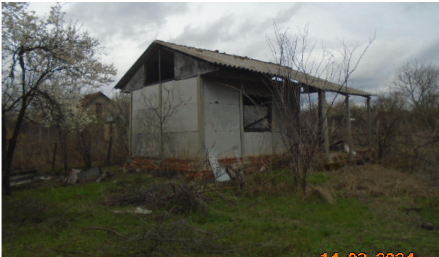
Изглед от югозапад
